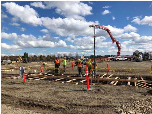
-Concrete pour in progress
